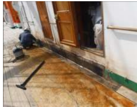
切り替えられた士官居住区エントランス側壁基部
