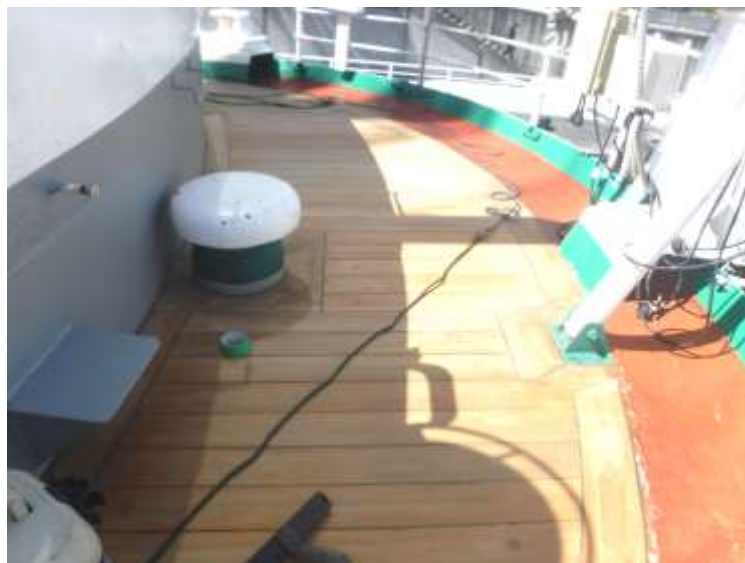
施工が完了したフード周り木甲板張替えとフード側壁基部切り替え
