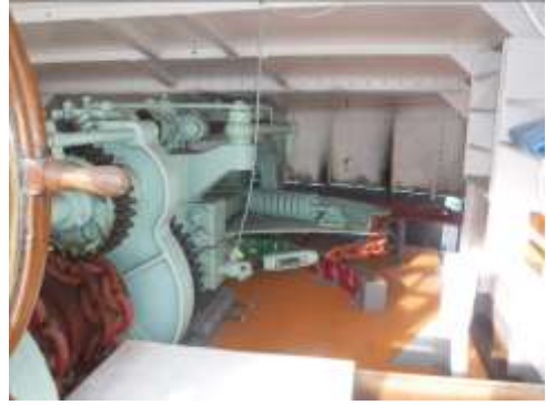
フード側壁基部切替え工事
