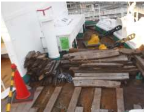
腐食した木甲板の撤去
